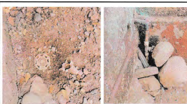
Foto 4: sustitución de llave de globo para paso de agua potable
