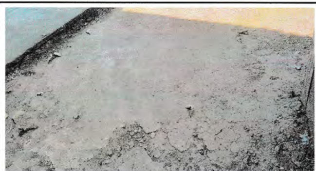
Foto 3: sustitución de plancha de concreto
