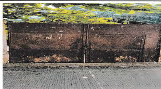
Foto 2: sustitución de porton de metal
