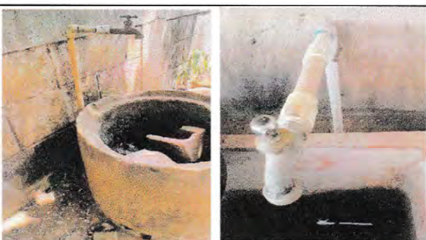
Foto 5: Sustitución de tubería PVC para agua potable
