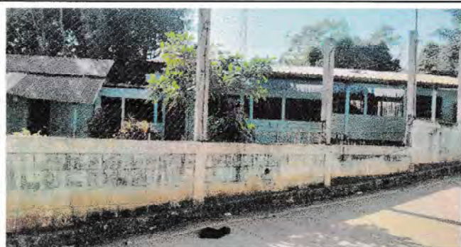
Foto1: Reparación de muro perimetral de block con soleras intermedias y columnas
